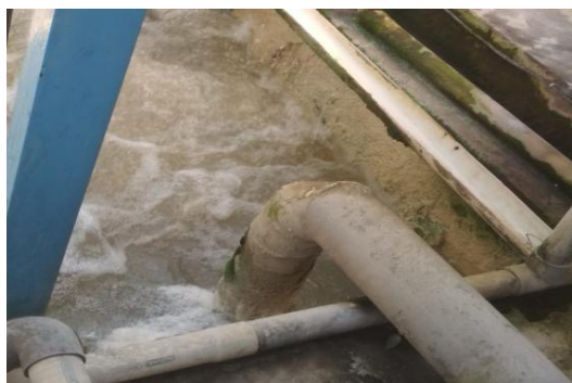
Gambar 9. Proses Koagulasi
