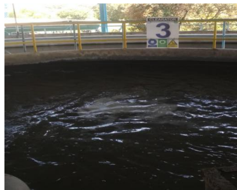
Gambar 12. Koagulasi dan Flokulasi Pada Sistem Clerator
