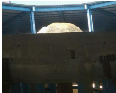
Gambar 11. Aerasi Pada Sistem Clearator
