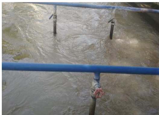
Gambar 7. Proses Aerasi
