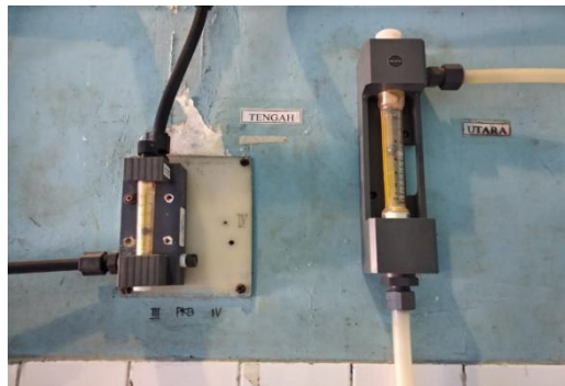
Gambar 17. Pengaturan Konsentrasi Klor
