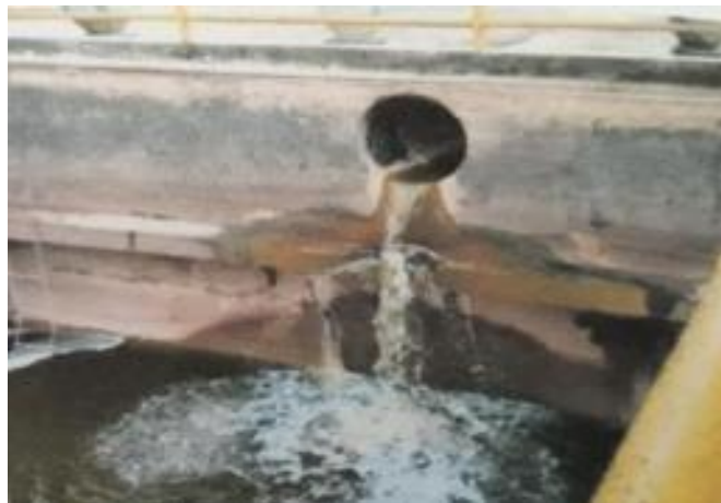
Gambar 3.6 Inlet Unit Pengolahan Limbah Cair
