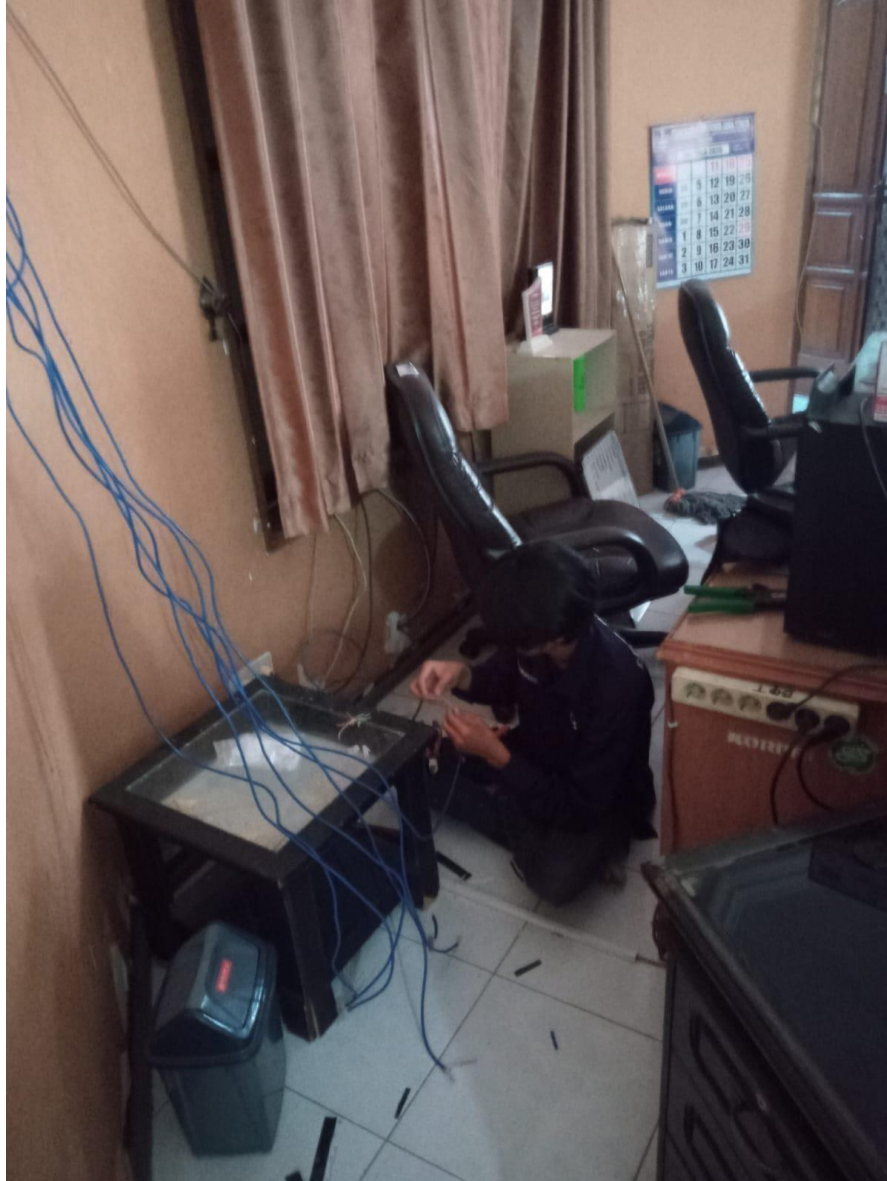
Gambar 4.5 Pemerataan Jaringan di Gedung Lantai 2
