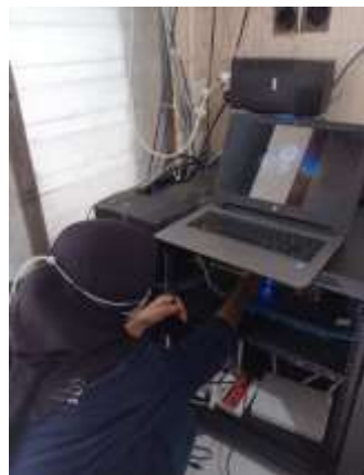
Gambar 22. Pengecekan Jaringan Oleh Tim Kerja Praktik Jaringan
