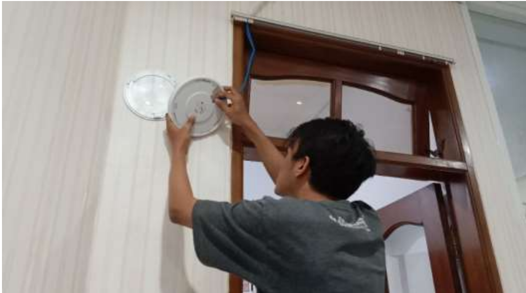
Gambar 23. Pemasangan Peralatan Setelah Dilakukan Pengecekan
