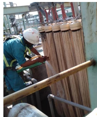
Gambar 13. Proses Pembersihan Membran Sumber: Dokumentasi Pribadi (2022)
