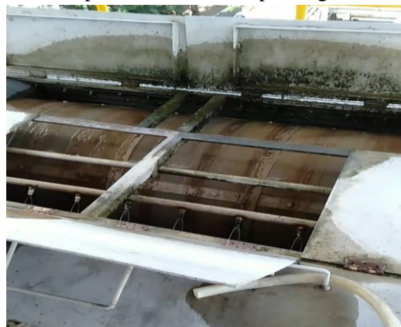
Gambar 8. Rotary Screen Sumber: Dokumentasi Pribadi (2022)
