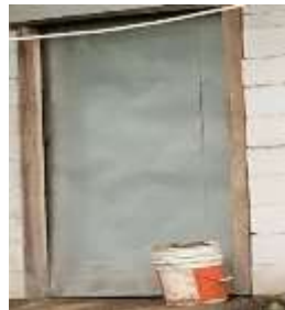
Gambar 5. Pintu ruang produksi
