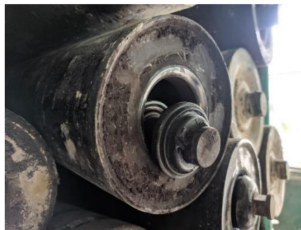
Gambar 4.13 Carrying Yang Mengalami Kerusakan / Jebol
