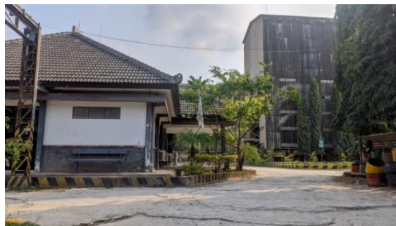
Gambar 4.1 Kantor Seksi Operasi Crusher
