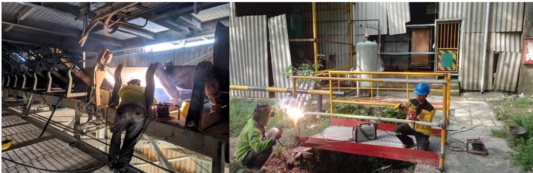
Gambar 4.15 Fabrikasi Frame Conveyor (Kiri), Fabrikasi Handrail (Kanan)
