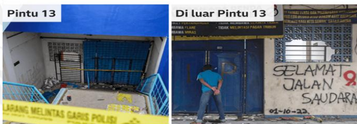
Ventilasi dekat pintu keluar dijebol
