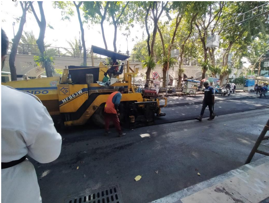
Dokumentasi kegiatan Pengawasan K3 pekerjaan pengaspalan jalan Alun-Alun Gresik
