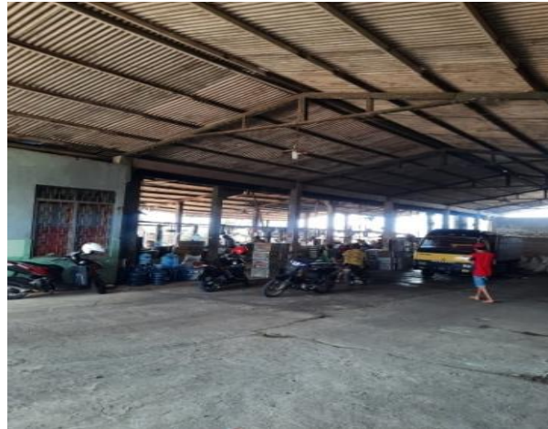
Gambar 2. 1 Pabrik Tahu UD. Mahmudi Jaya
