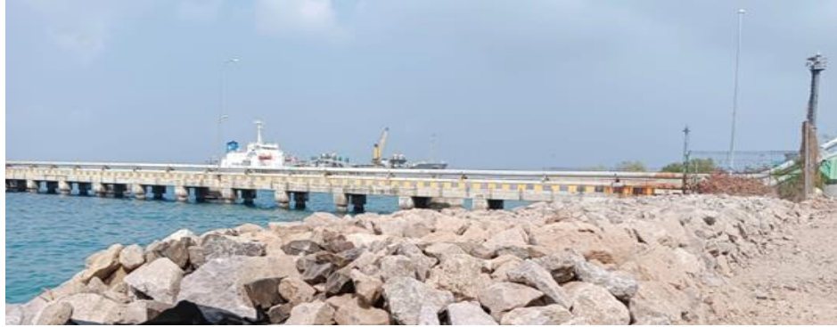
Gambar 4.14 Pengerjaan Proyek Tanggul Dermaga Selesai Dilakukan
