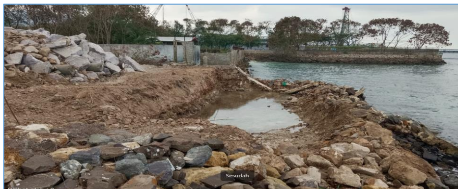
Gambar 4.13 Proses Pengerjaan Proyek Tanggul Dermaga
